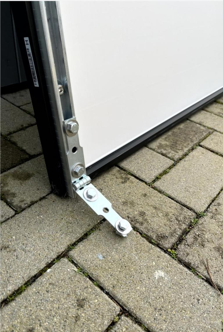
Nachdem ihr die Scharniere mit den Sechskantschrauben und den Schiebemuttern bestückt habt, fädelt ihr die Schiebemuttern des Scharniers in die Modulschiene ein.
