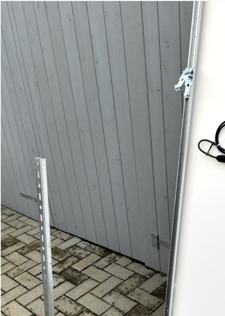
Scharnier in die Modulschiene einführen und auf ungefähre Höhe des freien Endes der verwendeten Schiene schieben.
