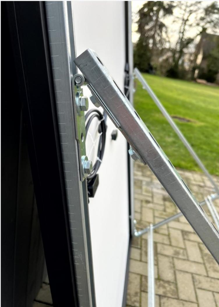
Die verwendete Schiene gegen die Modulschiene klappen. Und dabei das Scharnier mit den Schiebemuttern in die Schiene einführen.
