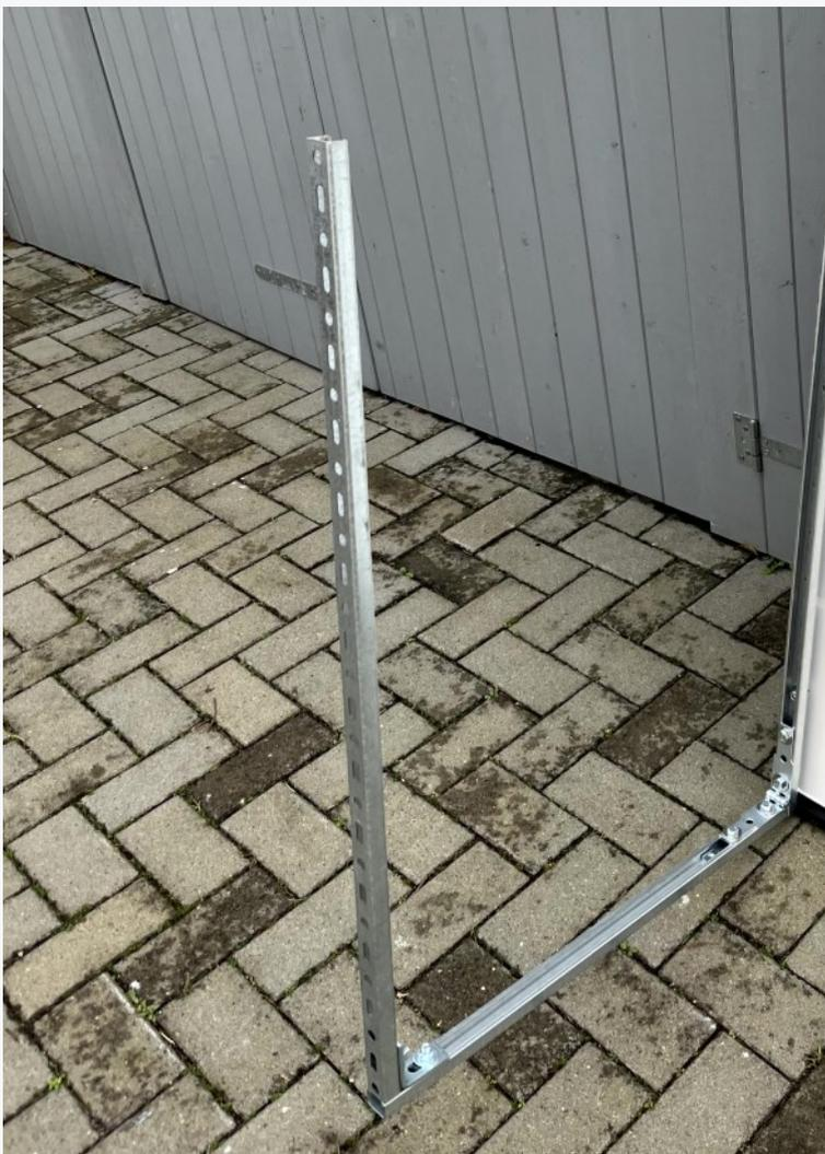
Die verwendete Schiene auf den freien Schenkel des Befestigungswinkel stecken und beide Schienen bündig ausrichten
