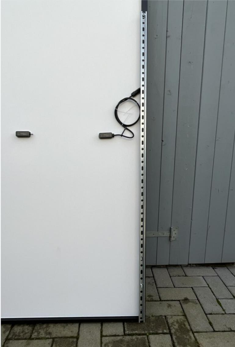
Die Sechskantmutter hinter den Solarmodulrahmen schieben und Zylinderkopfschraube anziehen, so dass noch Spiel ist.
