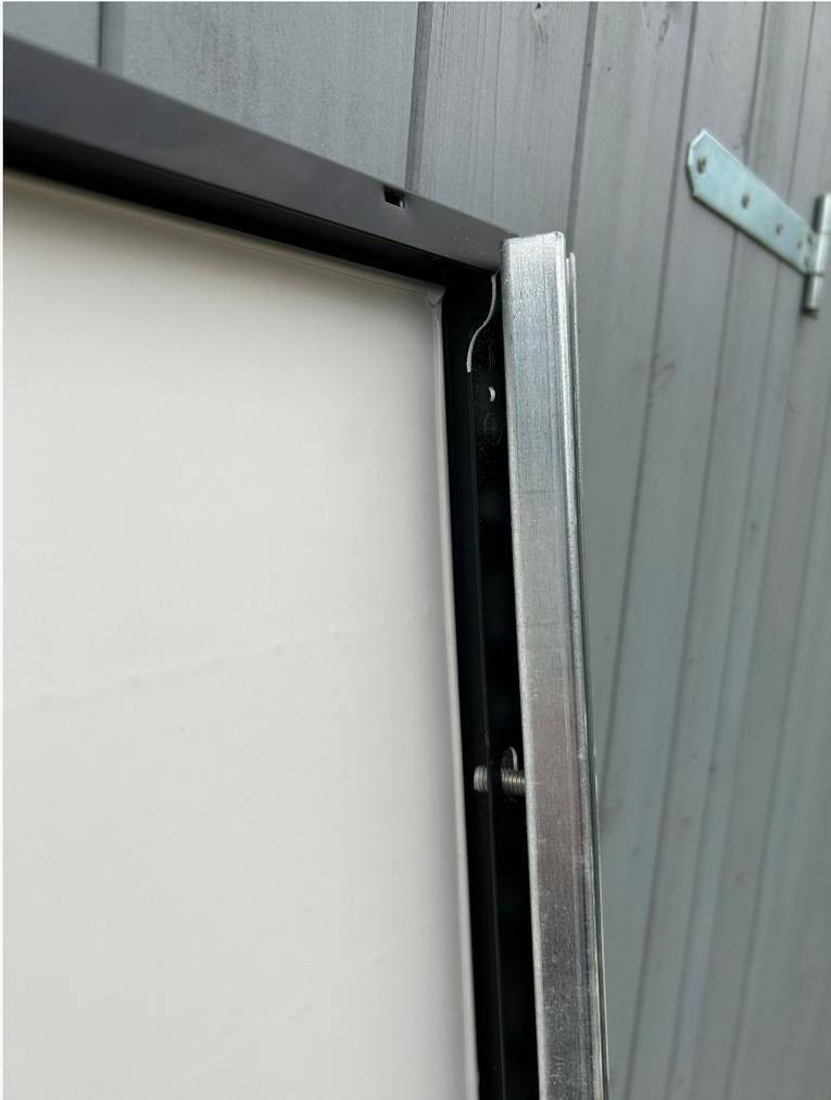
Die Schiebemutter hinter den Solarmodulrahmen schieben und Zylinderkopfschraube anziehen, so dass noch Spiel ist.
