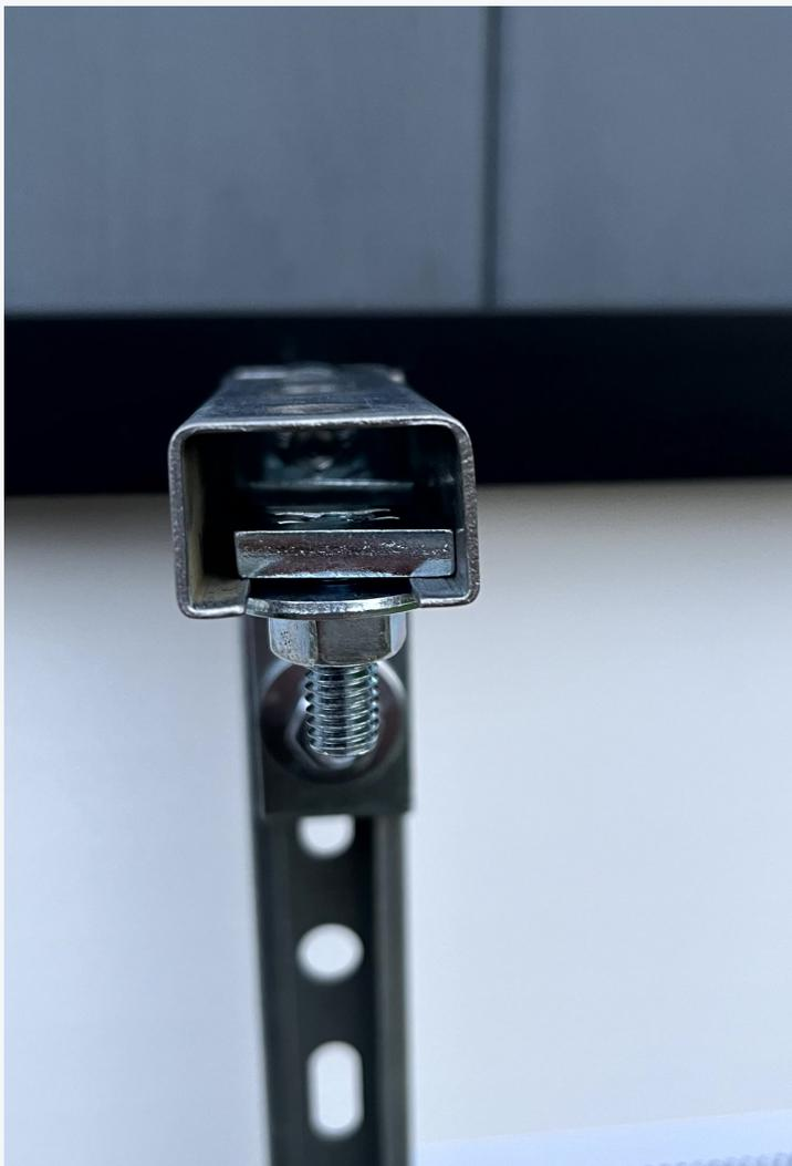
Hammerkopfschraube in 10cm Schiene einführen, so dass die Unterlegscheibe bündig mit der Schiene abschließt.
