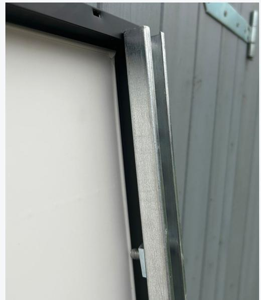
Die Modulschiene ist an der Oberante jetzt fast bündig mit der Oberkante des Moduls
