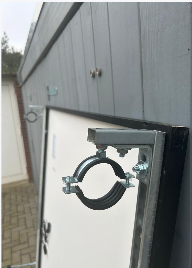
Brüstungsschelle auf die Hammerkopfschraube aufschrauben.
