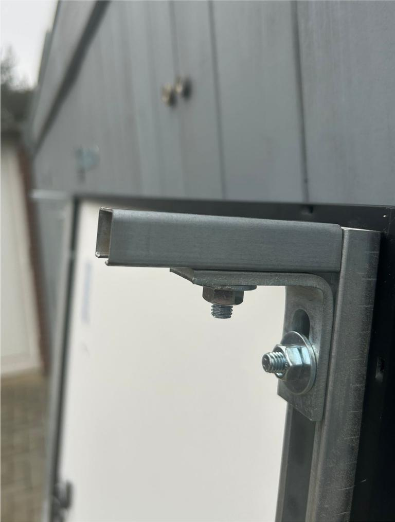
Befestigungswinkel mit den Schiebemuttern in das obere Ende der Modulschiene einführen, so dass noch ca. 2 cm Platz zum oberen Ende der Schiene ist.
